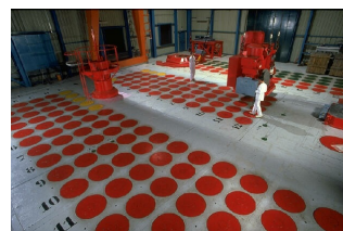
Hall d'entreposage des colis de déchets vitrifiés
