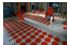
Hall d'entreposage des colis de déchets vitrifiés
