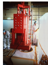
Puits d'entreposage et hotte de manutention
