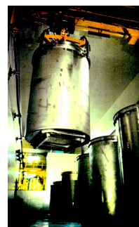
Atelier d'entreposage des colis
