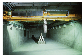
Entreposage des colis d'enrobés bitumineux
