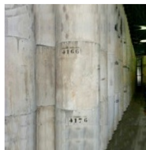
Coques béton contenant des fûts métalliques de boues et concentrats
