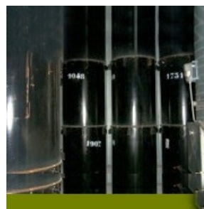
Conteneurs métalliques de concentrats cimentés
