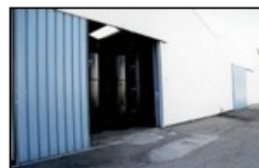
Parc d'entreposage des déchets radioactifs
