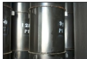
Conteneurs métalliques de déchets solides
