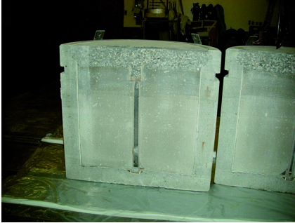
Coupe d'une coque béton pour expertise
