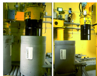
Fût métallique dans un conteneur en béton-fibres (atelier AD2, La Hague)
