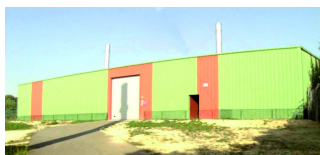
Bâtiment d'entreposage de déchets tritiés du CEA Valduc
