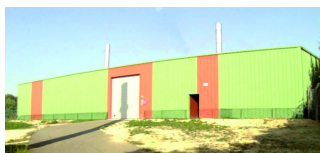
Bâtiment d'entreposage de déchets tritiés du CEA Valduc
