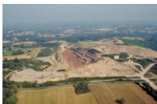
Site de Bellezane en cours d'exploitation
