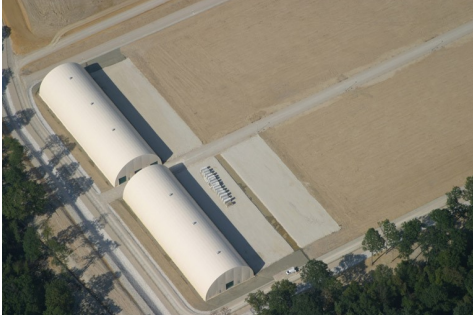
Vue aérienne d'un alvéole de stockage
