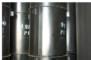
Conteneurs métalliques de déchets solides
