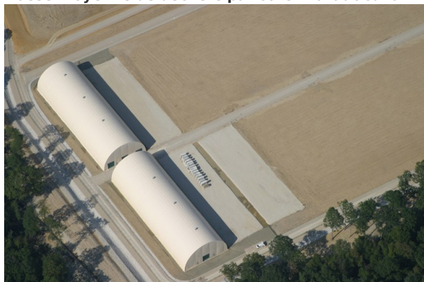
Vue aérienne d'un alvéole de stockage
