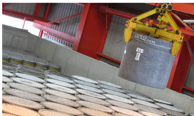
Stockage d'un colis de déchets FMA-VC
