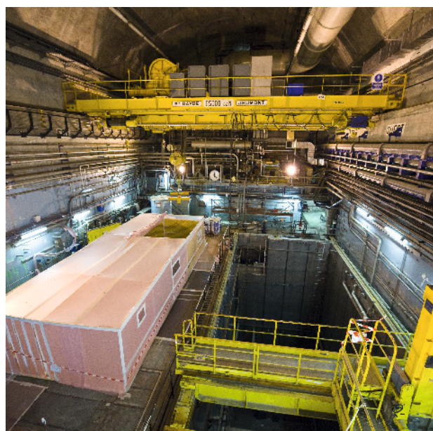
Démantèlement de la centrale EDF Chooz A
