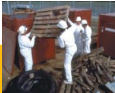
Démantèlement de la centrale de Brennilis
