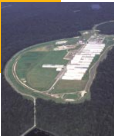
Centre de stockage FMA de l'Aube
