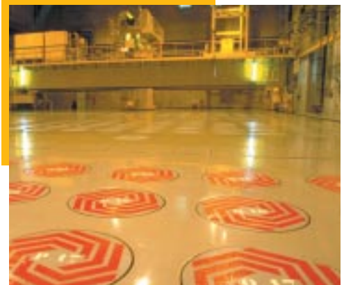
Hall d'entreposage de l'atelier de vitrification R7 - UP2 800 (COGEMA La Hague)
