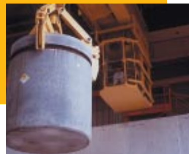
Dépôt d'une coque béton dans un ouvrage de stockage (Centre de stockage FMA de l'Aube)
